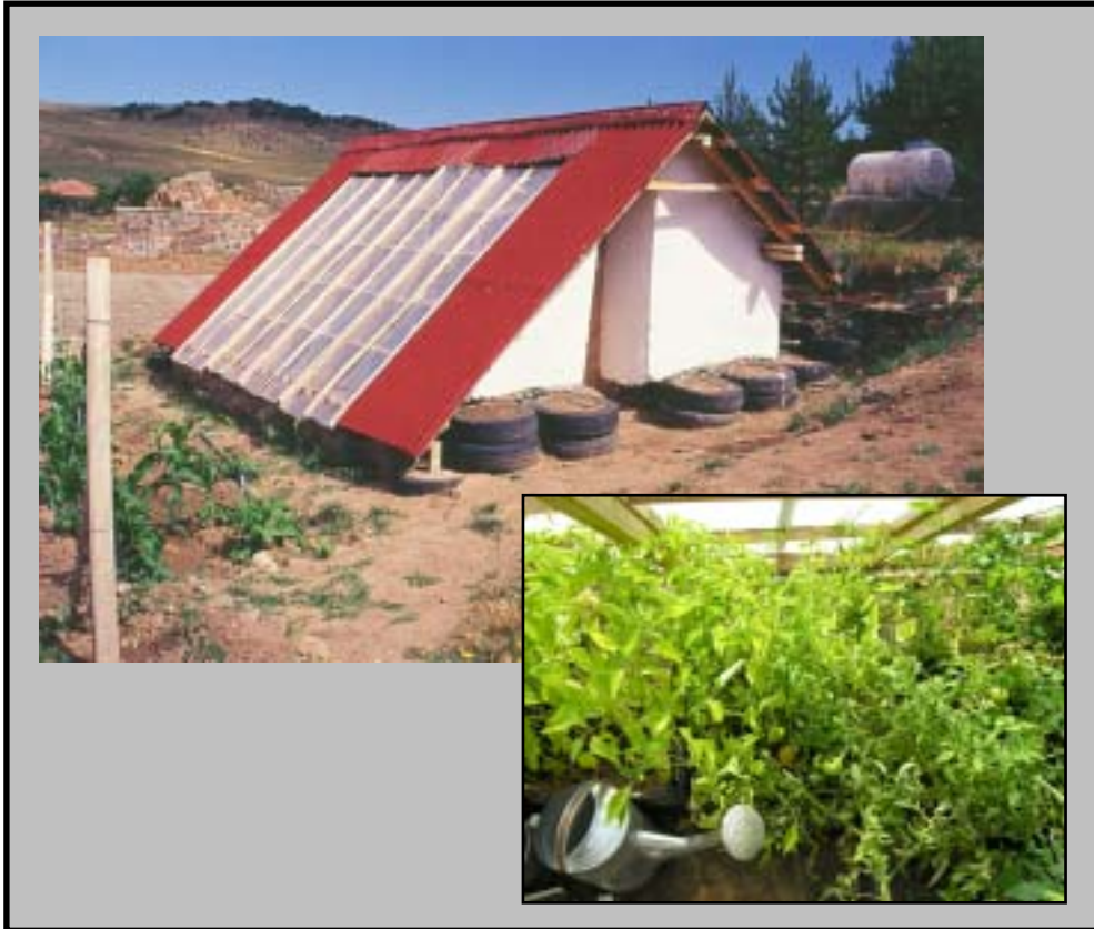
Şekil 22. Kerkenes Eko-Merkezde saman balyası duvarları ile bir sera kurulmuş ve performansı ölçülerek gözlenmiştir.
