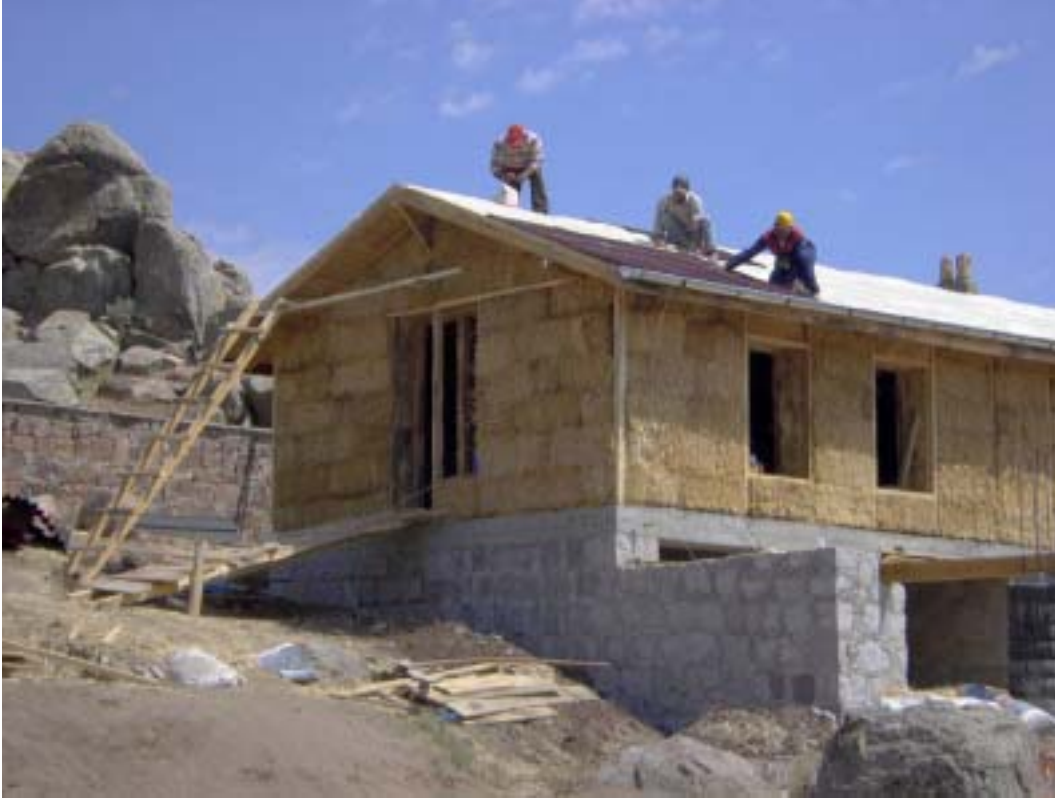
Şekil 6. Aynı katkılar Saman Evin inşaatının finanse edilmesine katkı sağlamıştır. Çimento, Yibitaş Yozgat Çimento - Yibitaş Lafarge, kum Sorgun Belediyesi ve çatı malzemesi Onduline tarafından sağlanmıştır.
