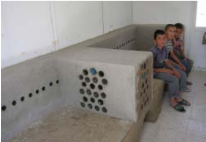
Şekil 18. Kerkenes Pergole Ev'de geri dönüştürülmüş kağıt, kum ve çimento kullanılarak yapılmış papercrete divan. Eski araba lastikleri alttaki kemerli depo hacminin yapımı için kalıp olarak kullanılmıştır. Saman, boş şişe ve tenekeler yan kısımların yapılmasında ve prefabrik yapının yalıtım kapasitesinin artırılmasında kullanılmıştır.
