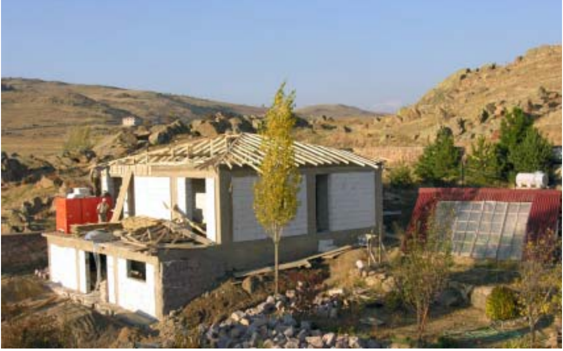
Şekil 8. Erdoğan Akdağ Araştırma ve Eğitim Merkezi Kasım 2005'de soğuk hava koşullarının inşaaı durdurmasından önce. Bina 2006 baharında tamamlanacak ve önerilen eğitim aktivitelerine ev sahipliği yapacaktır.
