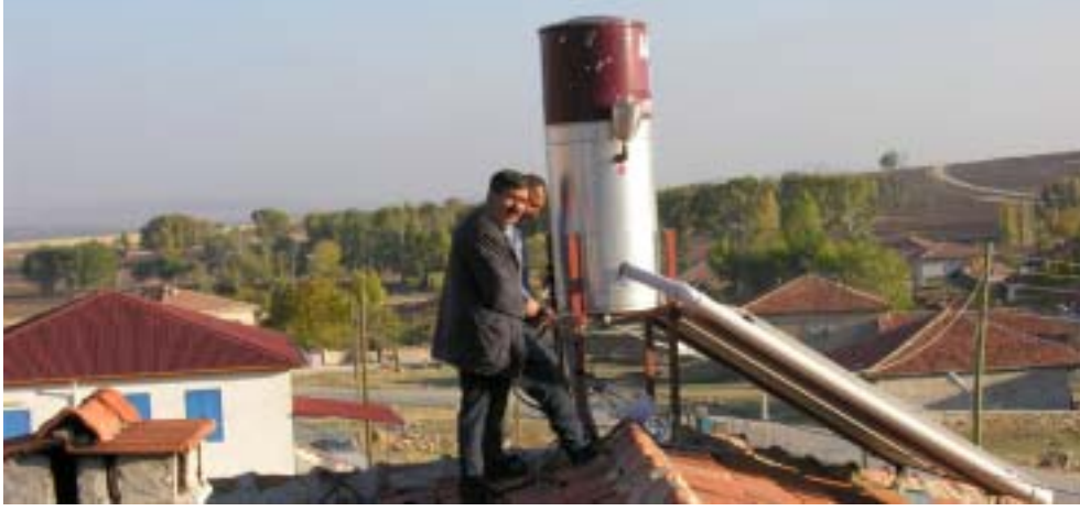
Şekil 21. Kerkenes Kazı Evi çatısındaki güneş enerjili su ısıtma sistemi.
