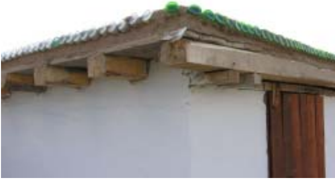
Şekil 17. Geleneksel kerpiç çatıda geri dönüştürülmüş şişeler.
